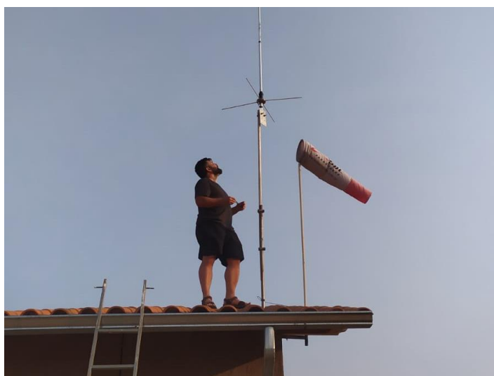
Figura 1: Manutenção na antena de rádio comunicador.
