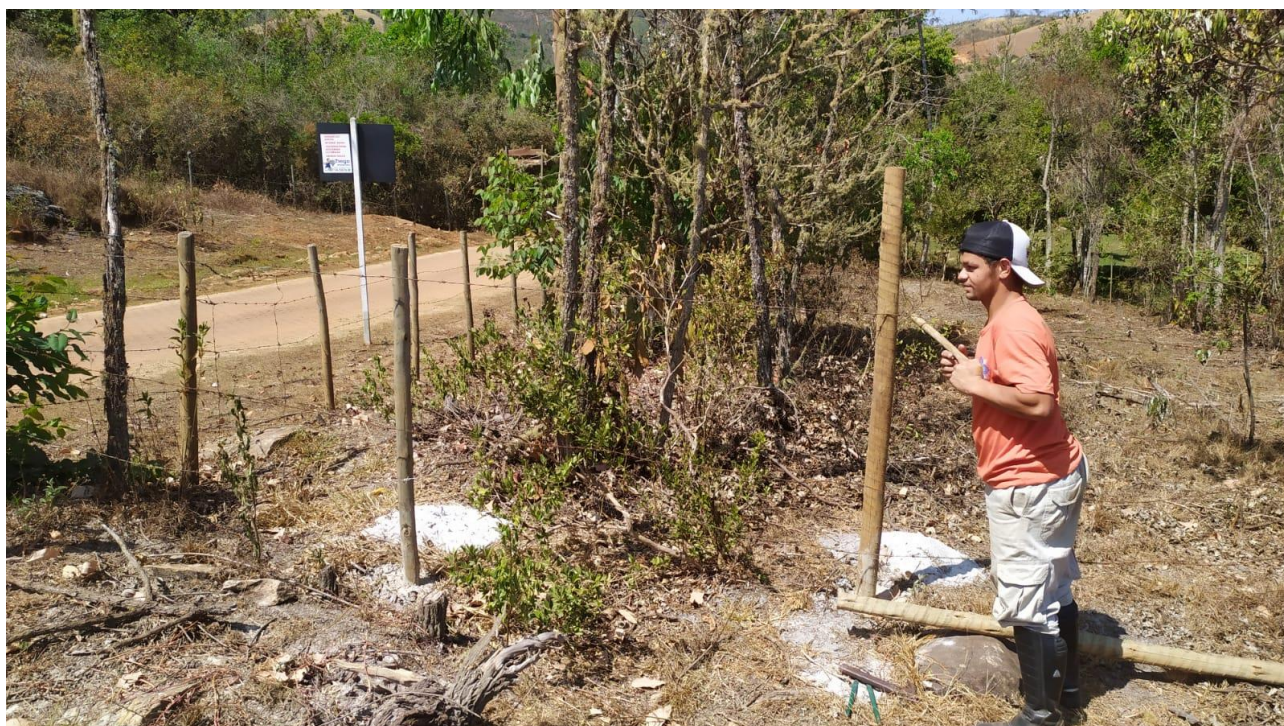
Figura 26: Reparo da cerca para impedir entrada de animais.
